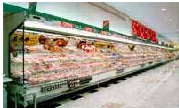
Beispiel für 3x Temperaturzonen = 3x XM679K (1x CX660 reicht aus)
